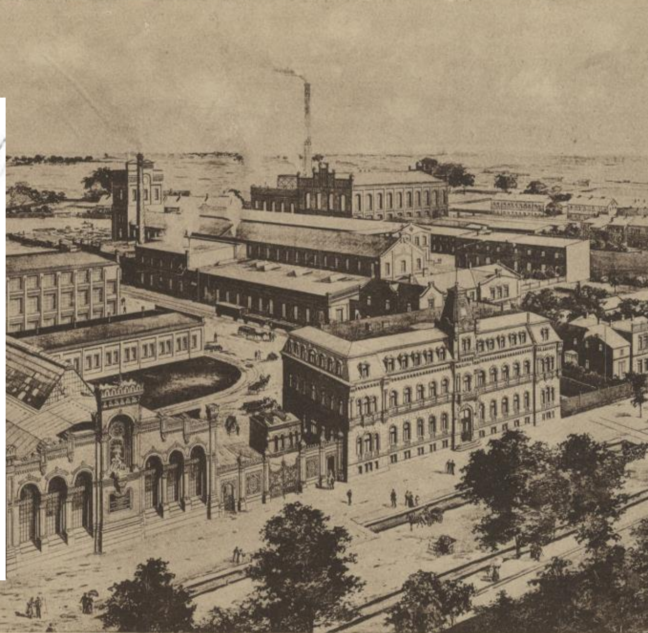
Общество „Всеобщая Компания Электричества“ Общій видъ зданій завода и конторъ въ г. Ригѣ.
